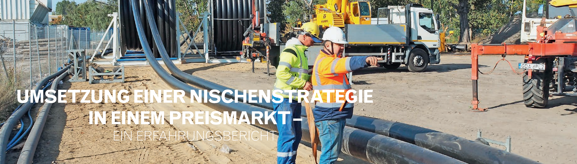
Verlegung einer flexiblen Rohrleitung von BRUGG in Danzig.
